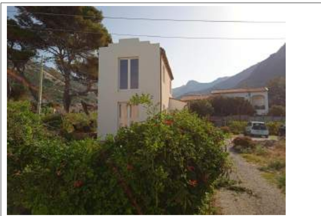
Descrizione: FOTO 3 Prospetto lato sud-ovest
