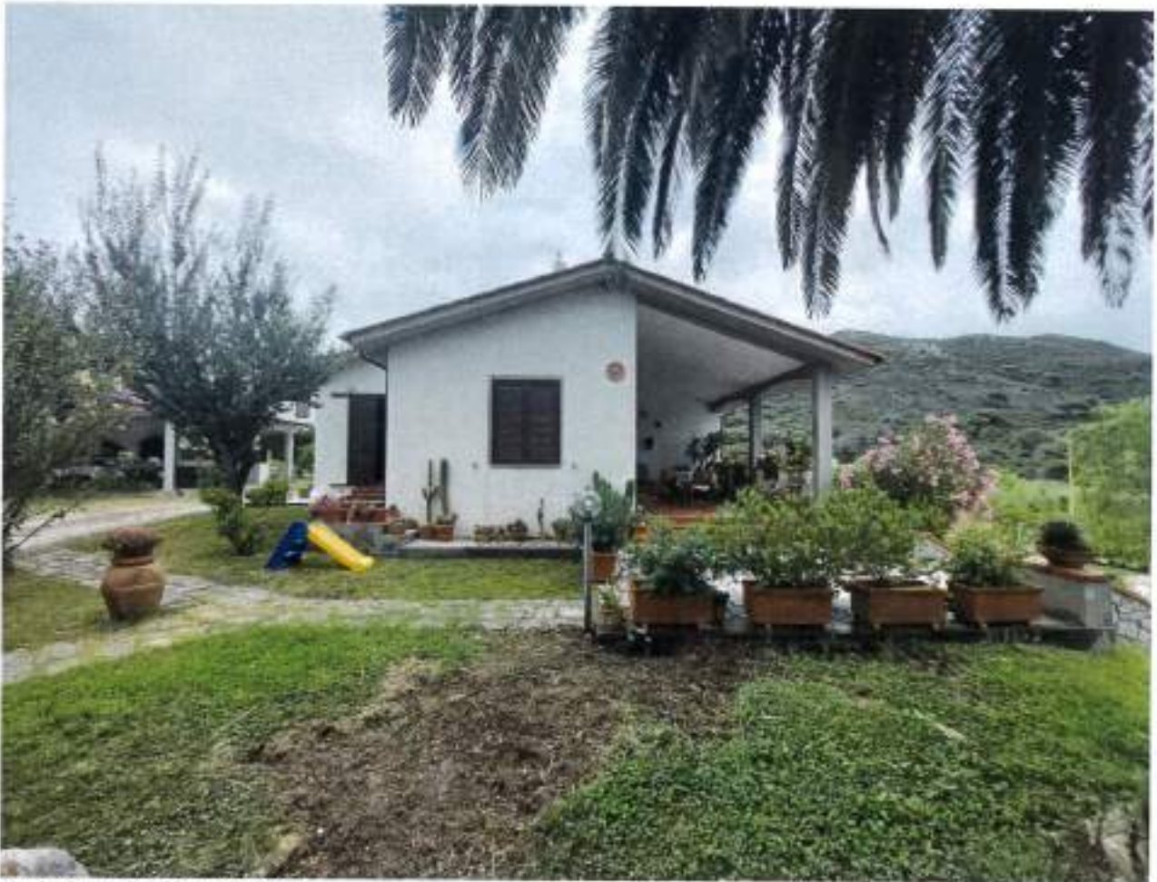
Descrizione: Prospetto Ovest
