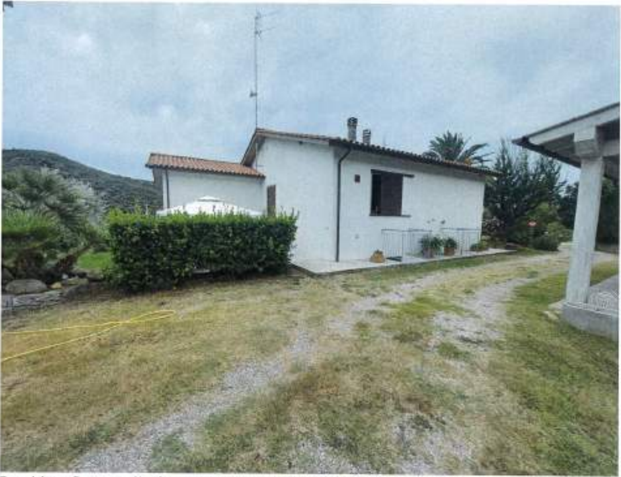
Descrizione: Prospetto Nord, non sono presenti elementi architettonici di valore.
