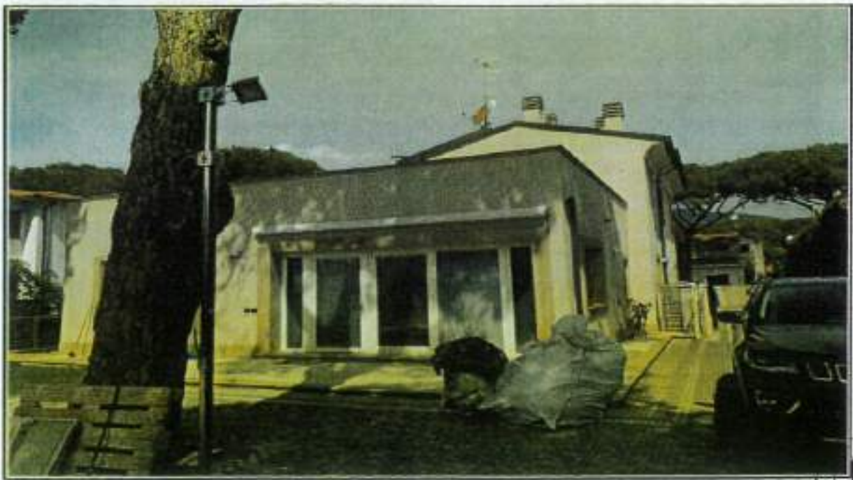
Descrizione: - Vista lato SUD
