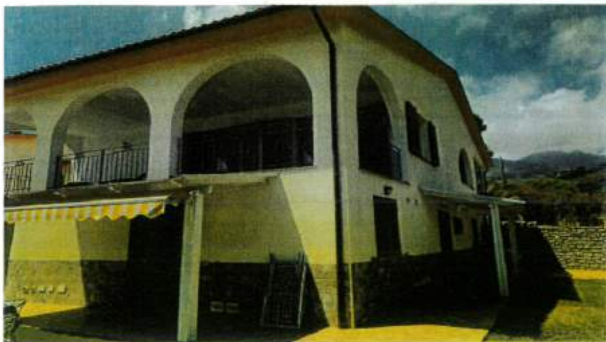
Descrizione: - Vista lato NORD - OVEST
