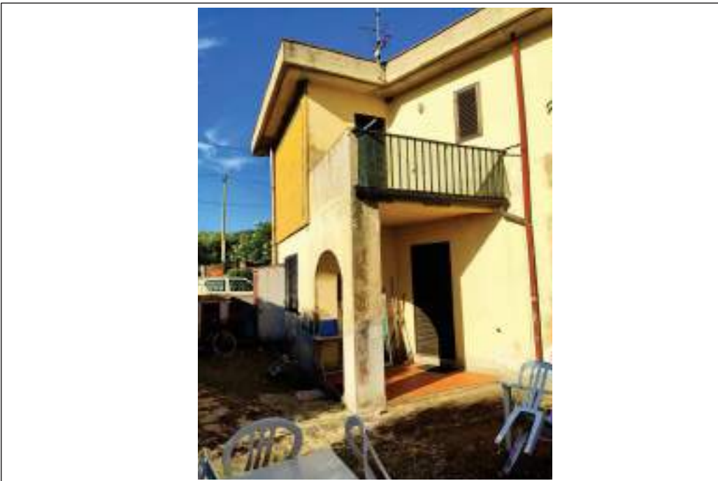
Descrizione: Foto di prospetto al portico d'ingresso all'abitazione, dal giardino interno
