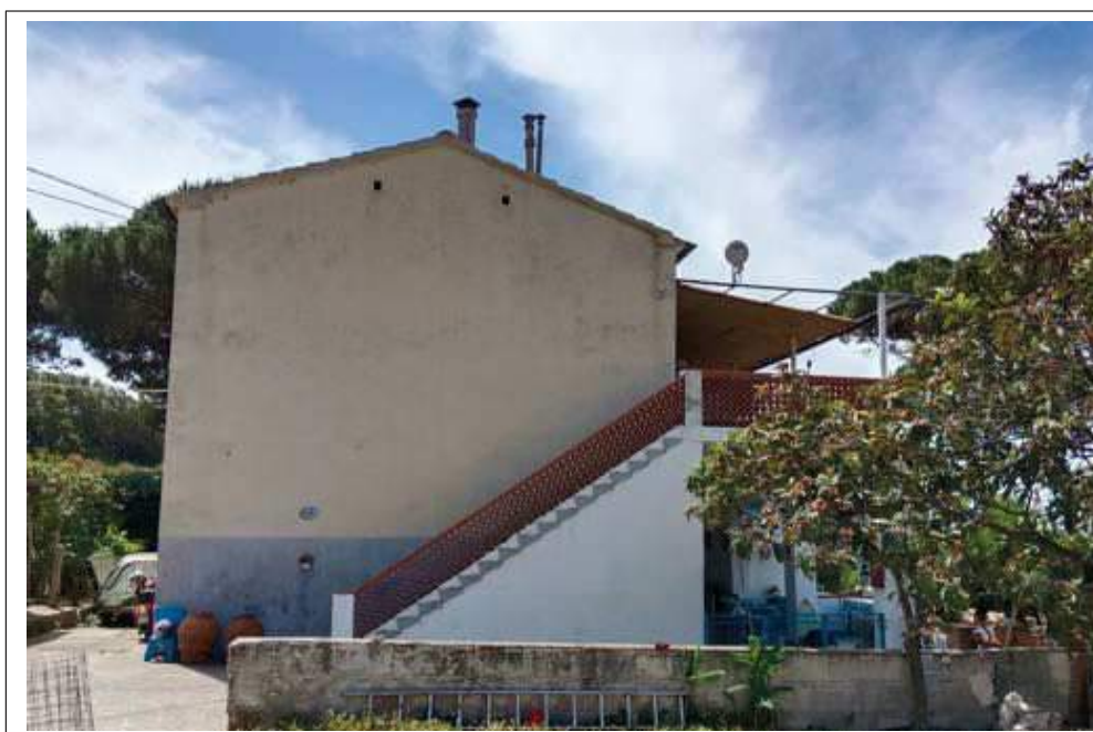
Descrizione: punto di ripresa della facciata Nord;
