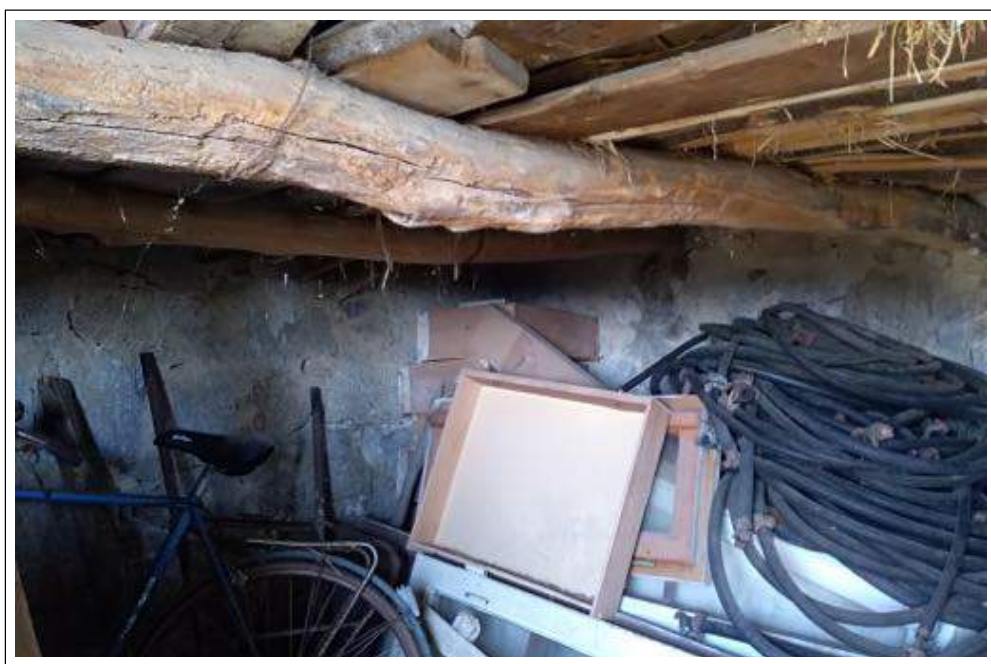
Descrizione: punto di ripresa interno;
