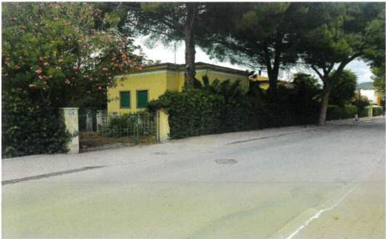
Descrizione: - Vista lato NORD - OVEST
