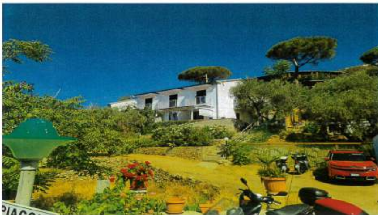
Descrizione: - Vista lato SUD
