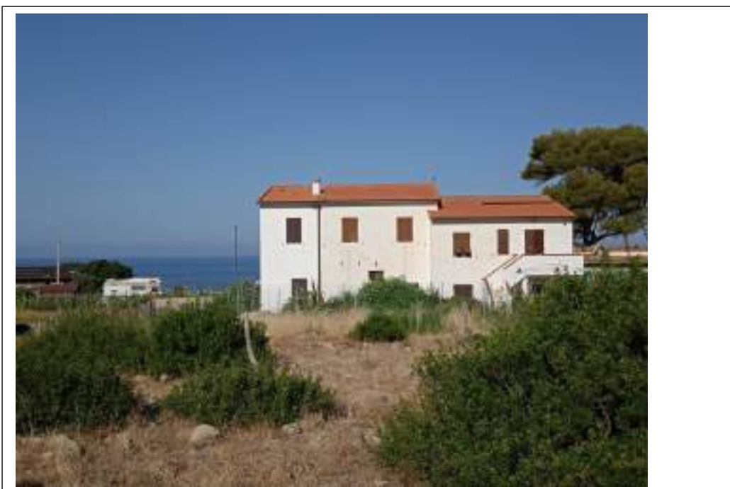
Descrizione: FOTO 3 Prospetto lato est
