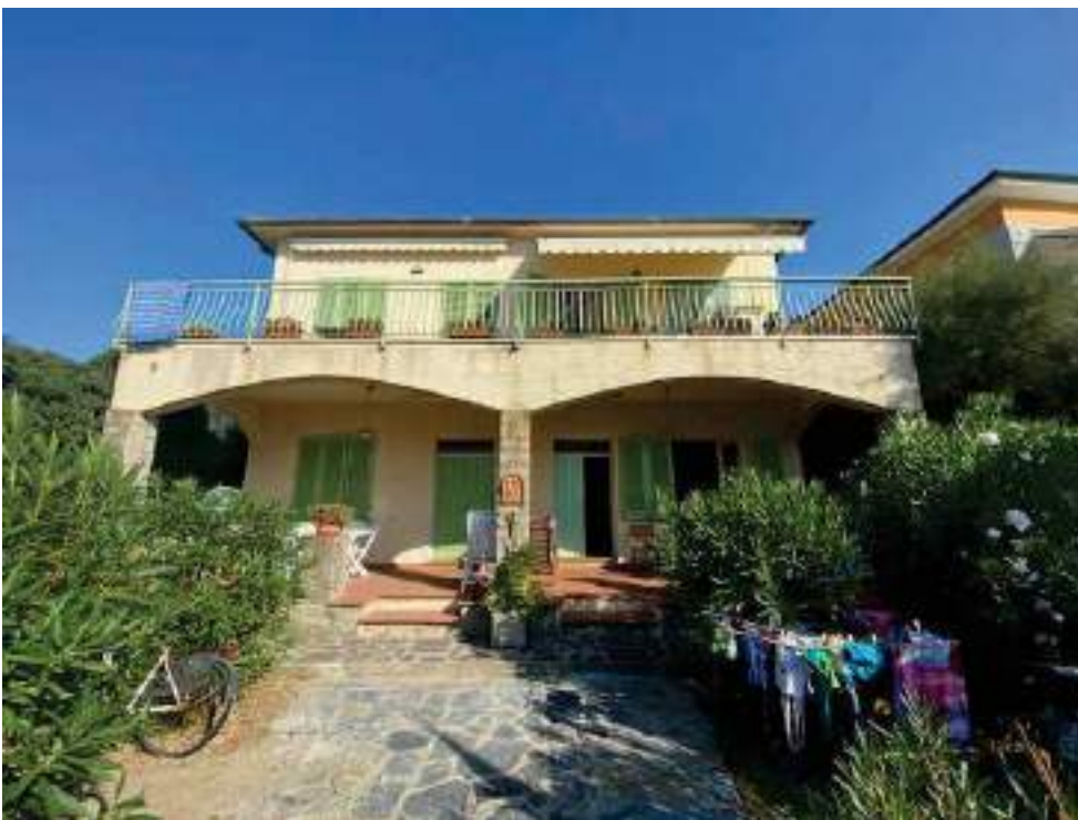
Descrizione: prospetto principale (Sud)
