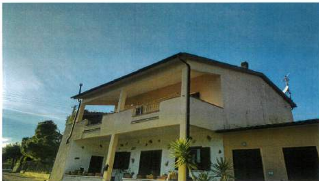
Descrizione: - Vista lato sud
