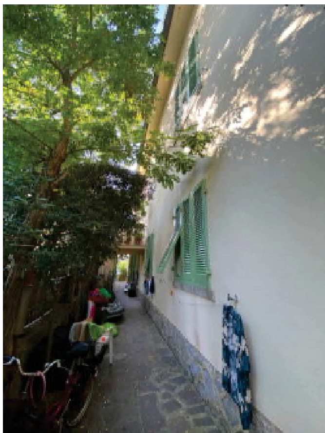
Descrizione: prospetto Ovest
