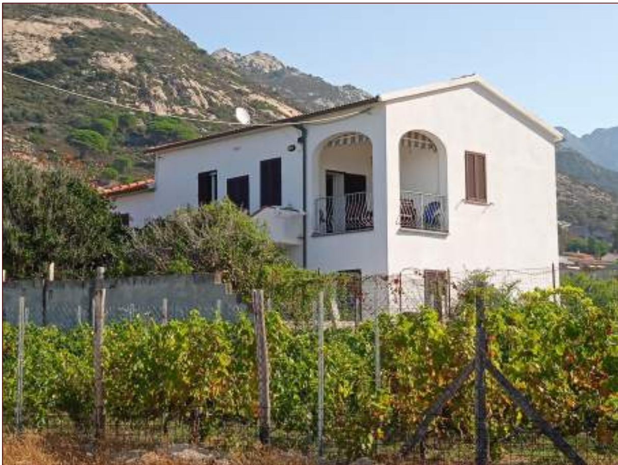
FOTO 1 - Prospetto lato ovest
