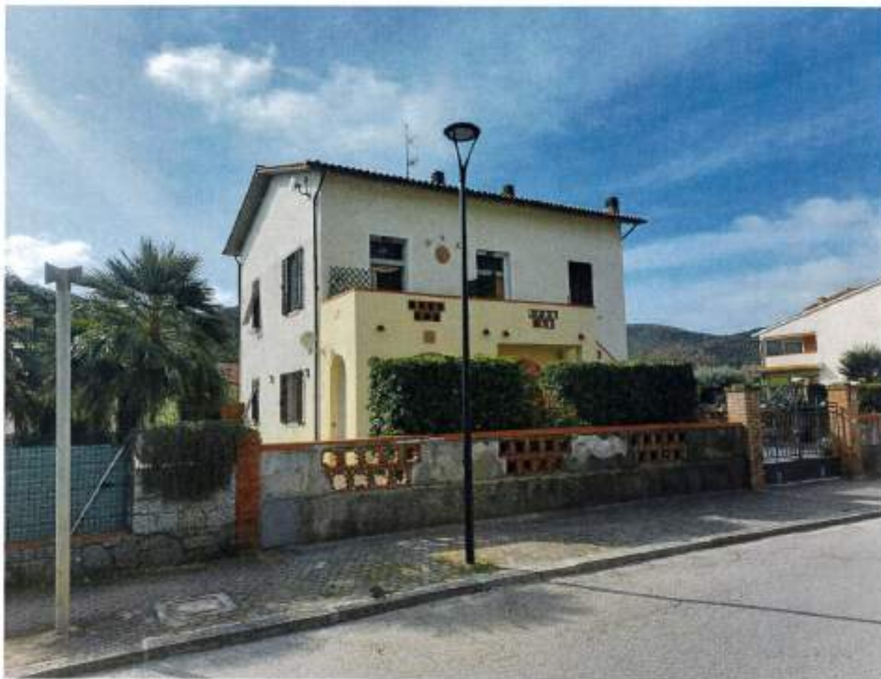
Descrizione: Vista prospetti lati Nord ed Est, non sono presenti elementi architettonici di valore
