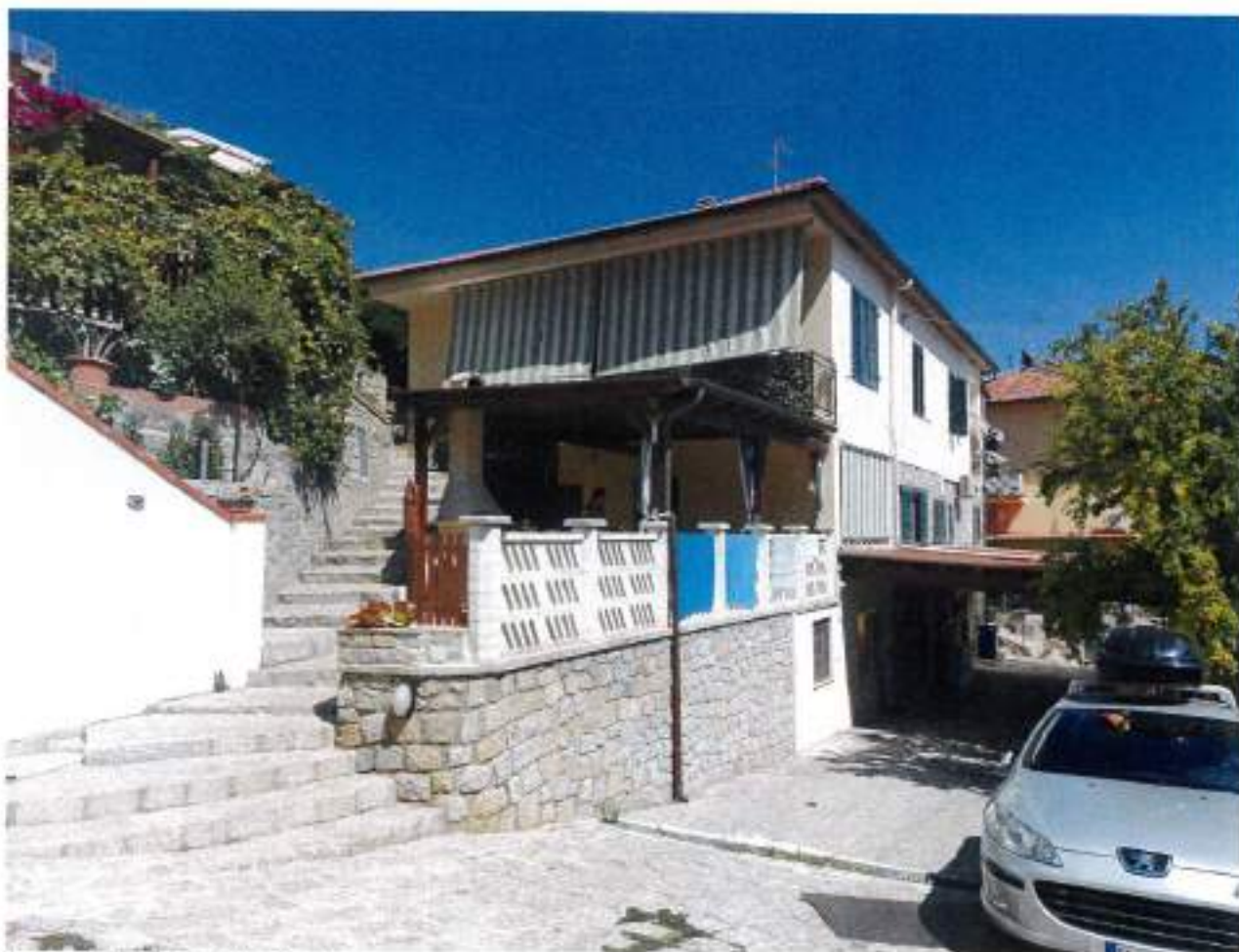
Descrizione: prospetto Ovest
