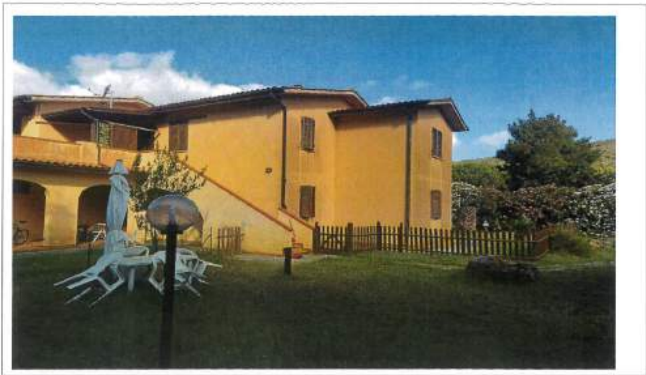
Descrizione: Vista lato est n. 2
