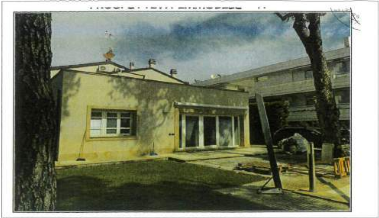
Descrizione: Vista lato SUD / 2
