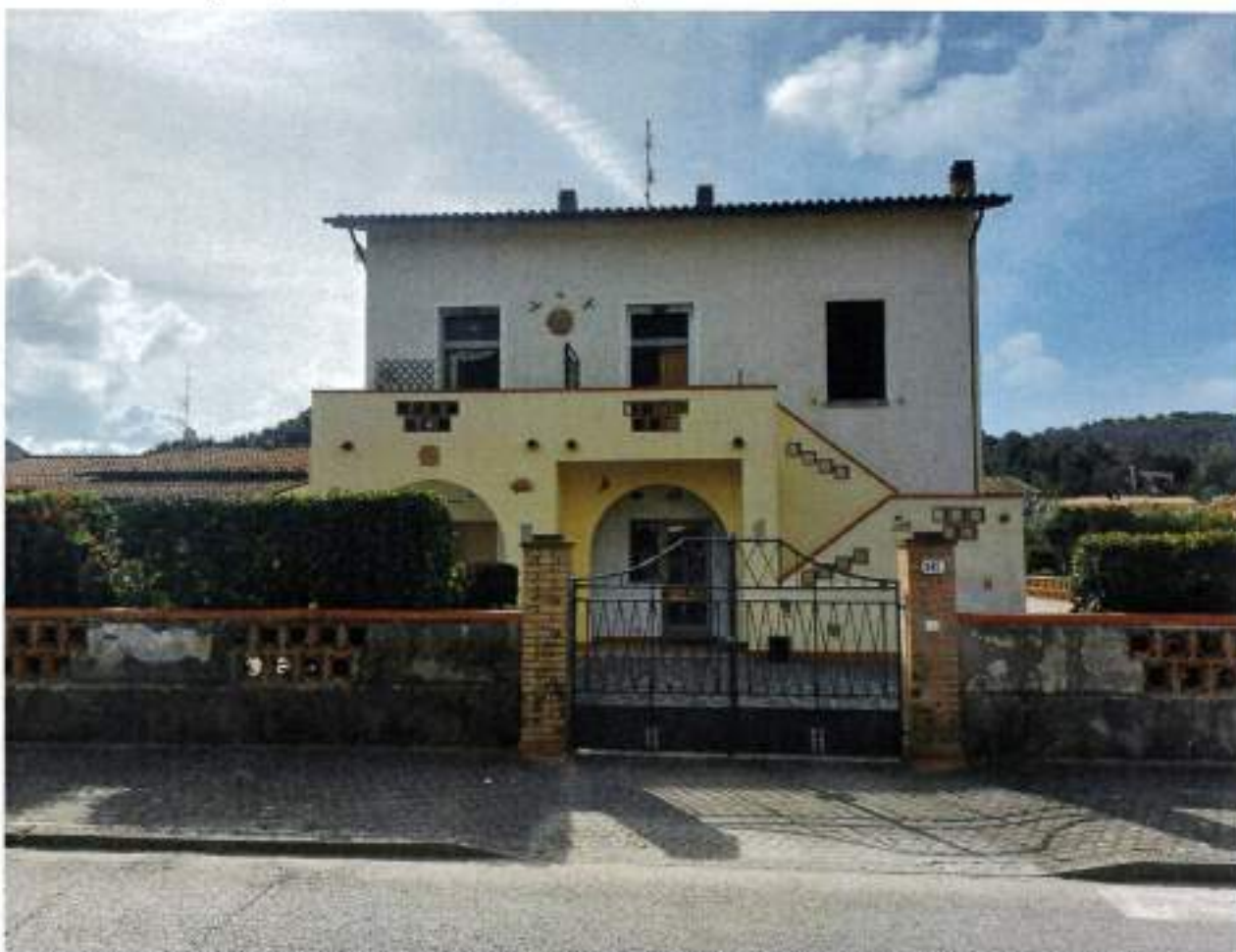
Descrizione: Prospetto Nord, facciata principale, non sono presenti elementi architettonici di valore
