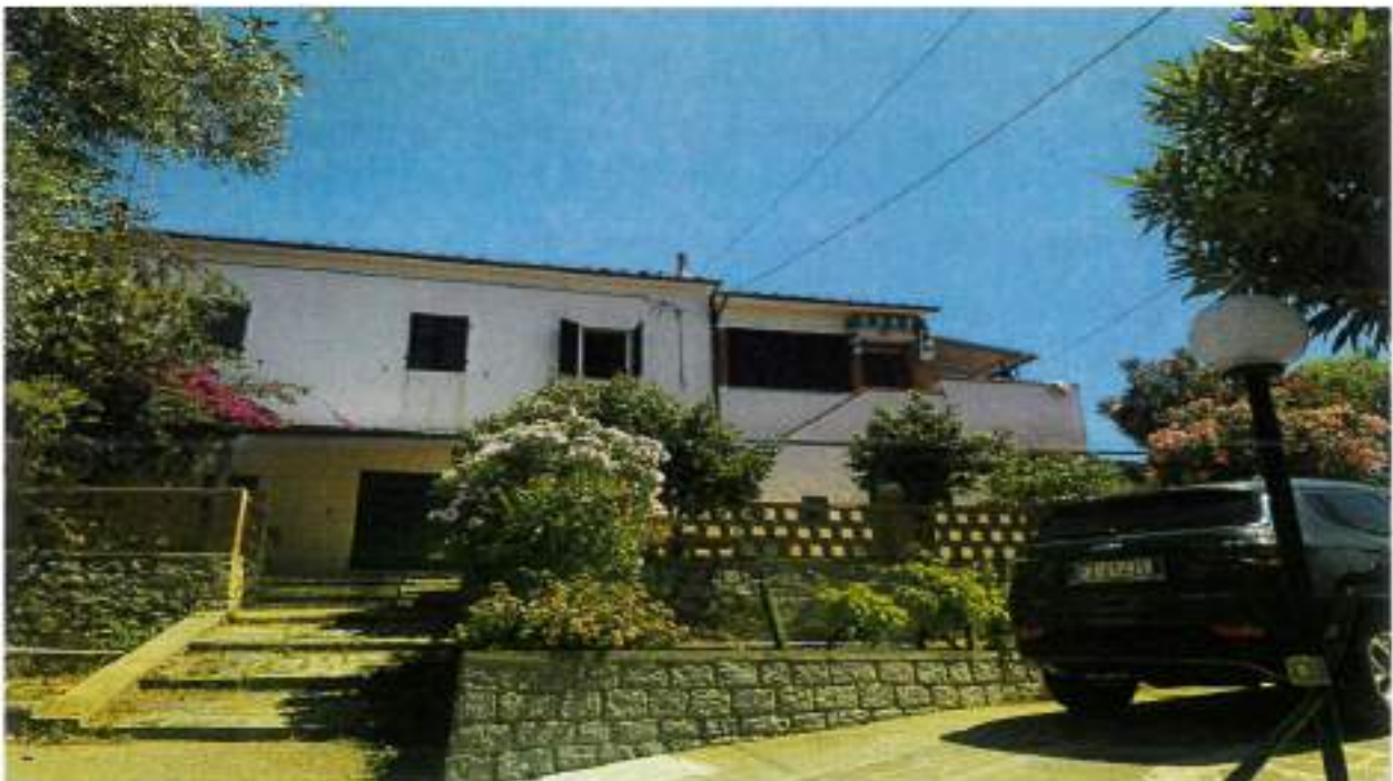
Descrizione: - Vista lato sud
