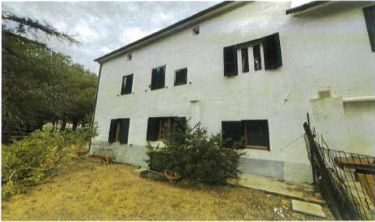
Descrizione: Vista lato SUD
