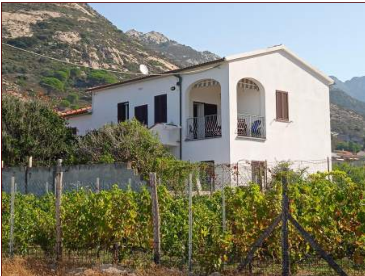
FOTO 1 - Prospetto lato ovest
