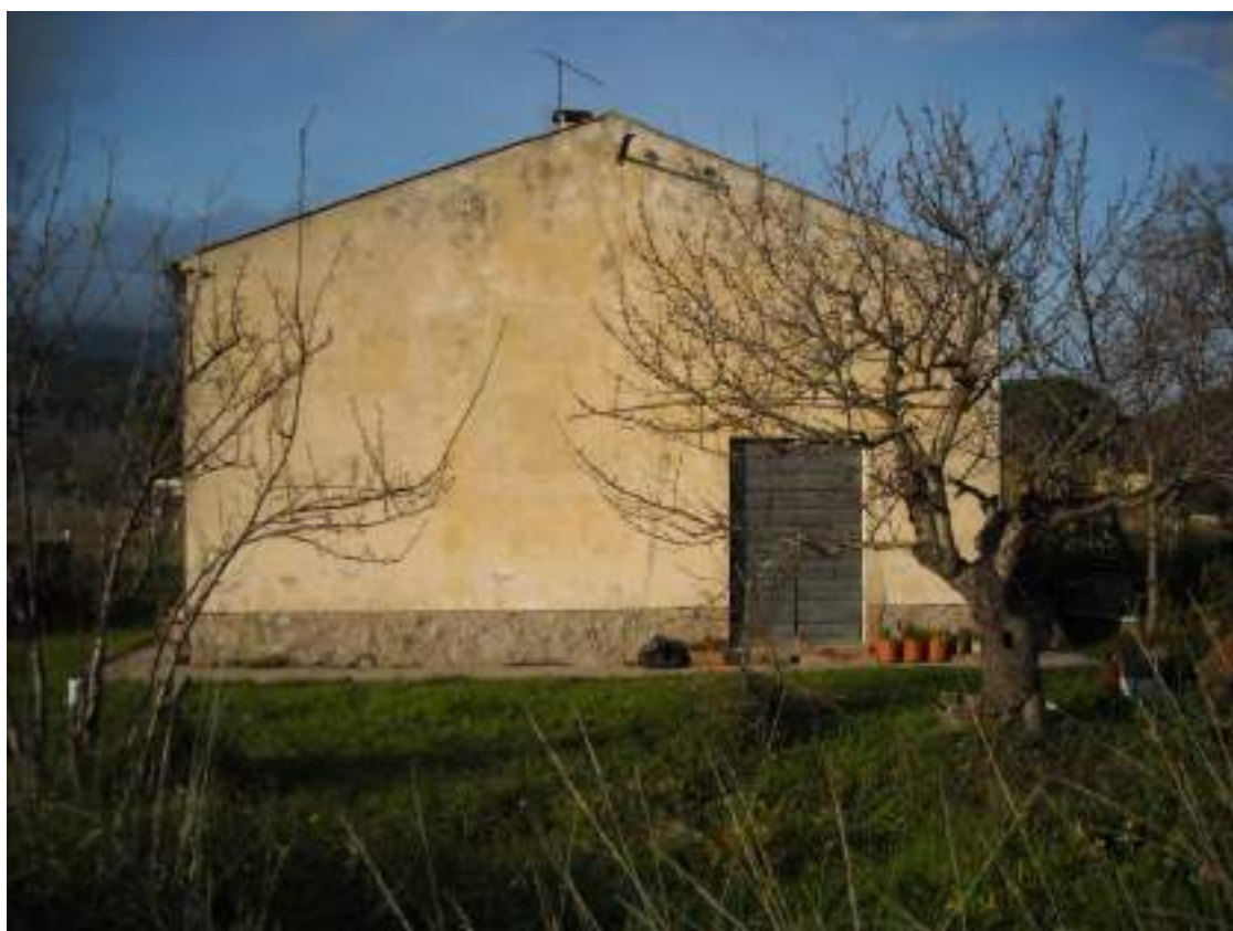
Prospetto laterale destro
