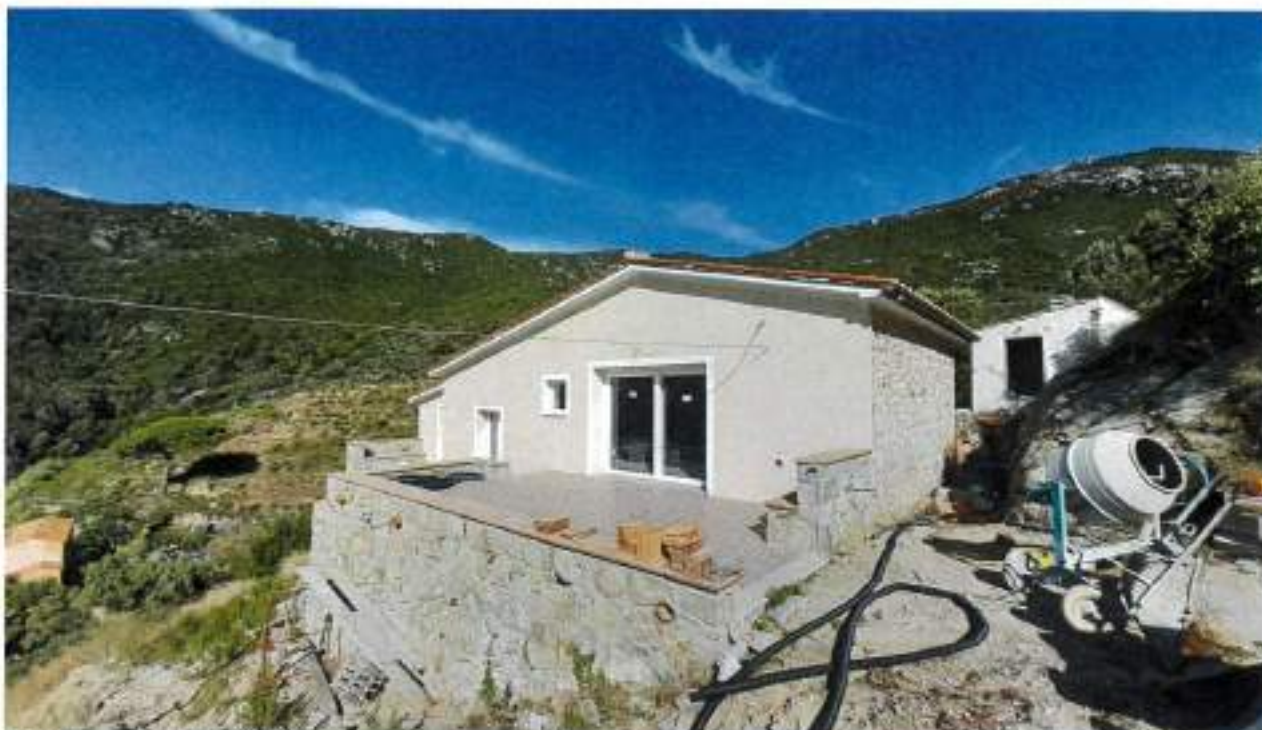
Descrizione: Prospetto Sud
