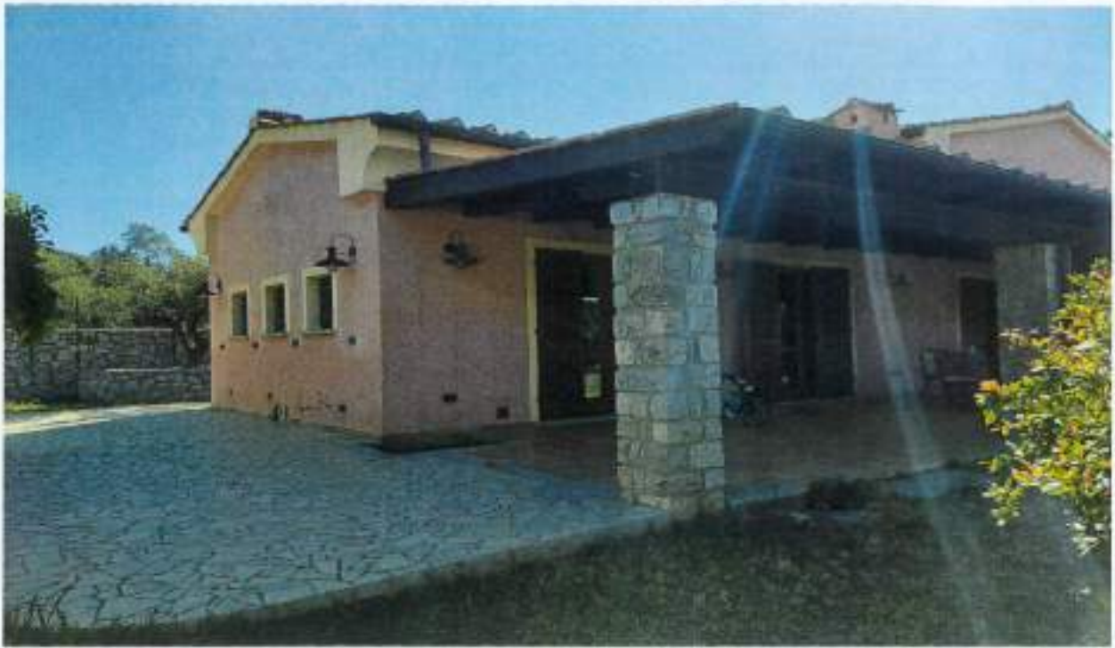
Descrizione: Vista lato EST
