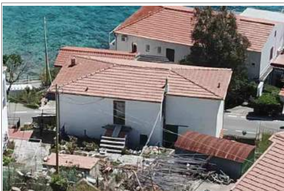
Descrizione: punto di ripresa della facciata tergale lato Nord-Ovest; non sono presenti elementi di pregio
