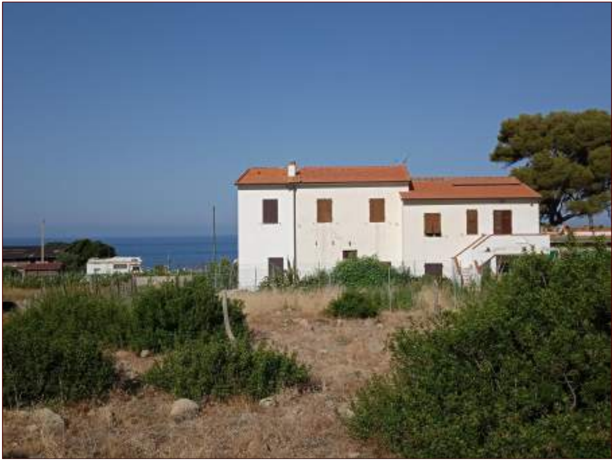
FOTO 3 - Prospetto lato est
