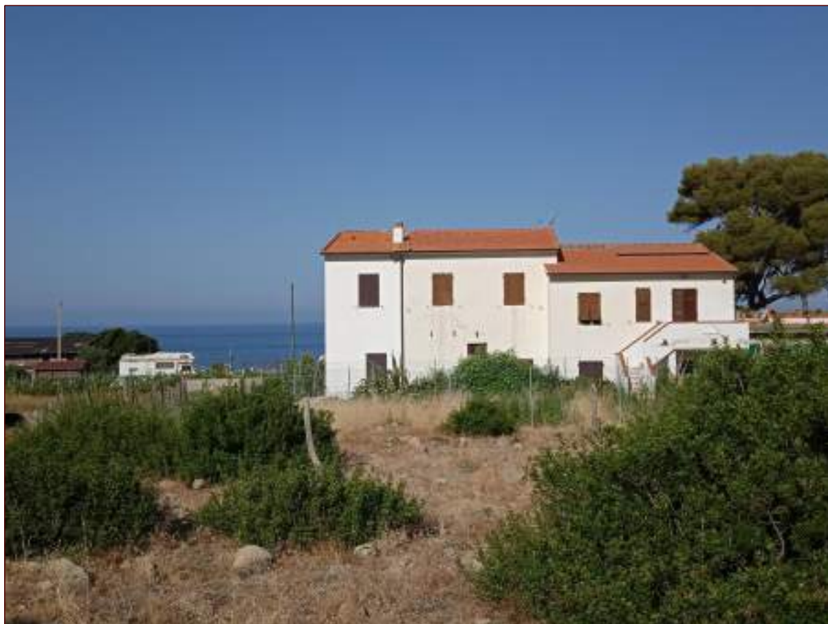
FOTO 3 - Prospetto lato est
