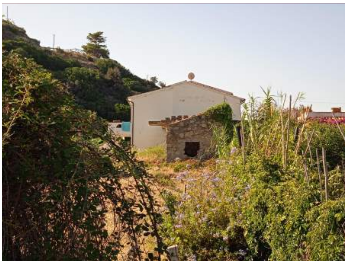
FOTO 4 - Prospetto lato nord
