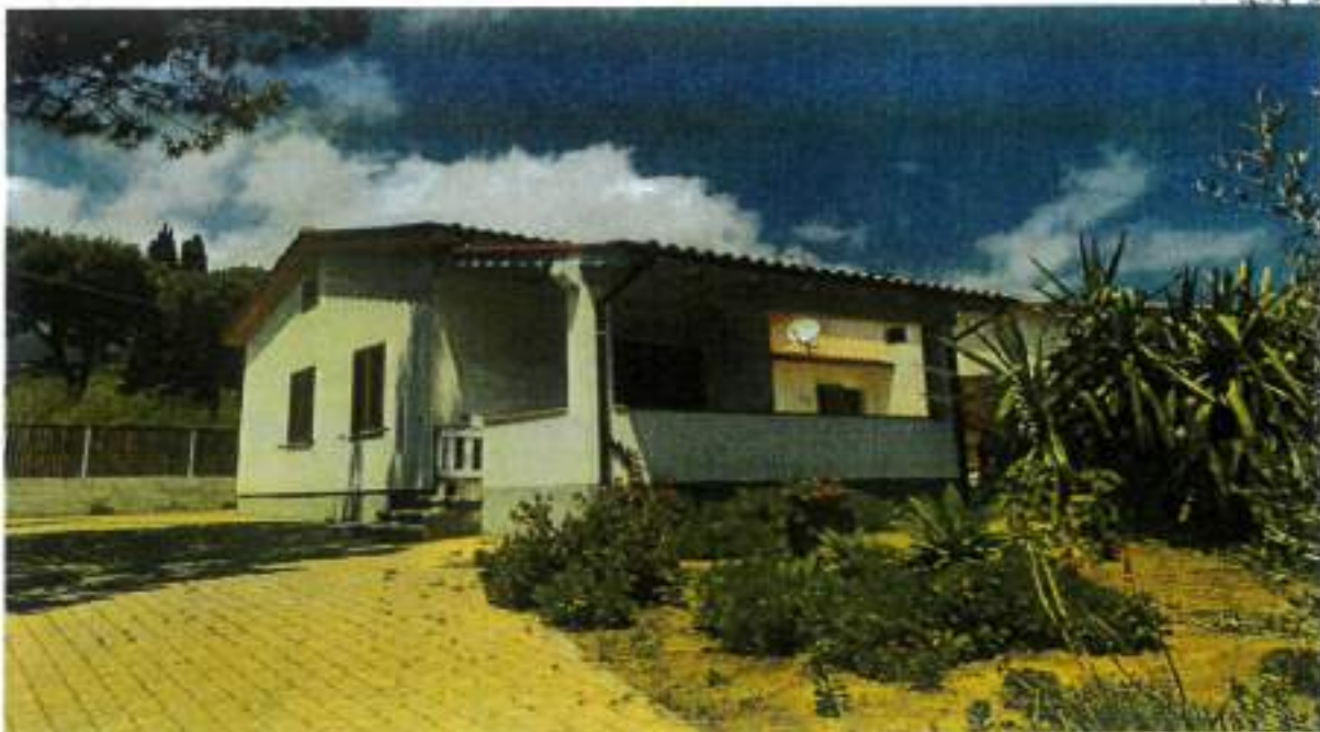
Descrizione: LATO SUD-OVEST
