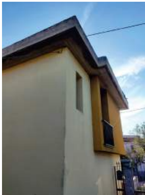
Descrizione: Foto di dettaglio della grondaia
