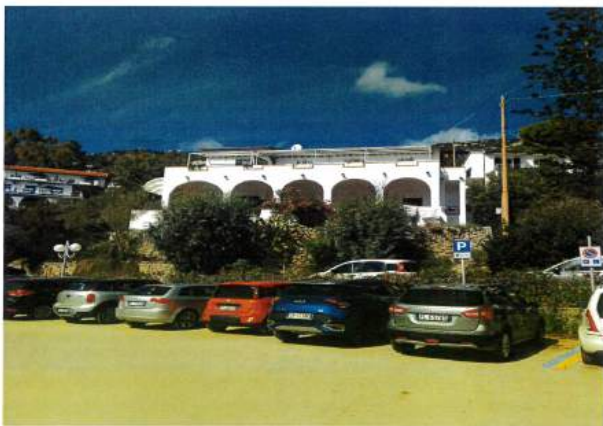
Descrizione: - Vista lato sud -
