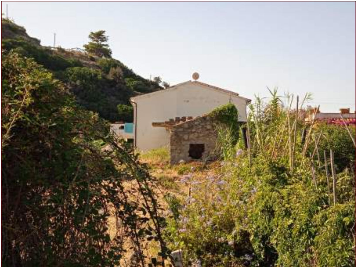
FOTO 4 - Prospetto lato nord
