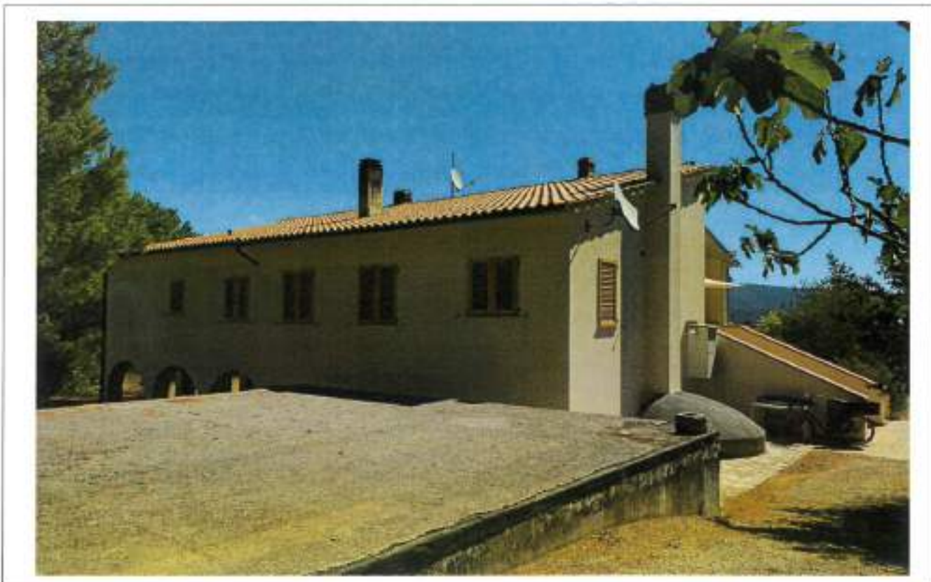
Descrizione: Vista SUD -OVEST
