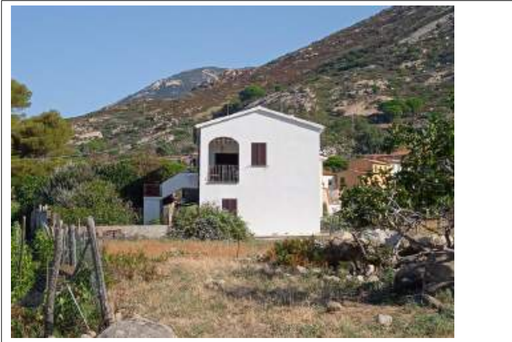
Descrizione: FOTO 2 Prospetto lato sud
