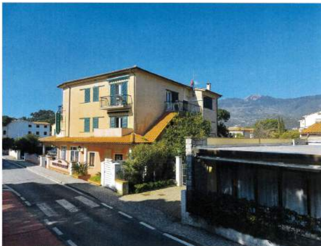
Descrizione: Vista prospetti lato Sud ed Est, non sono presenti elementi architettonici di valore
