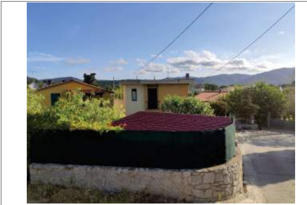
Descrizione: Foto di prospetto, dalla salita di Via del Crino
