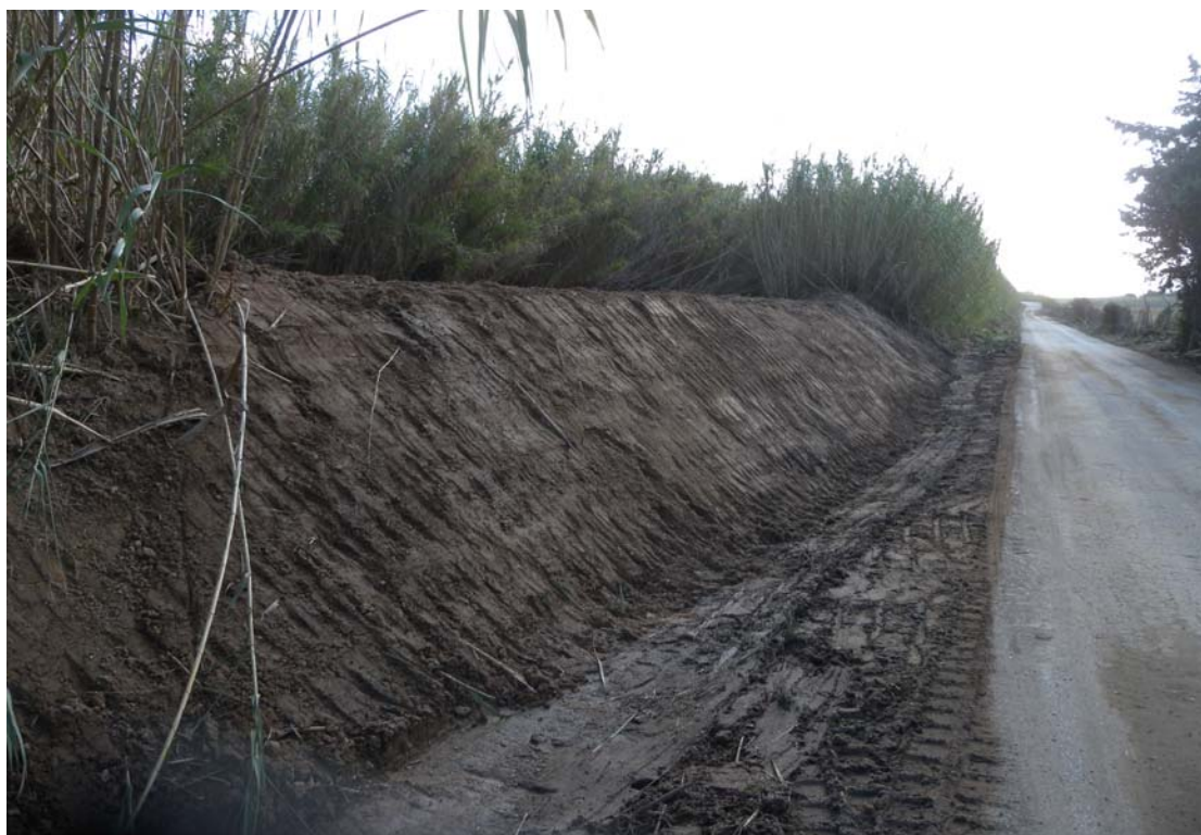
Figura 3.2 – Il tratto di argine ripristinato dopo il «dam break» del 7.11.2011 visto dalla strada per la Bonalaccia
